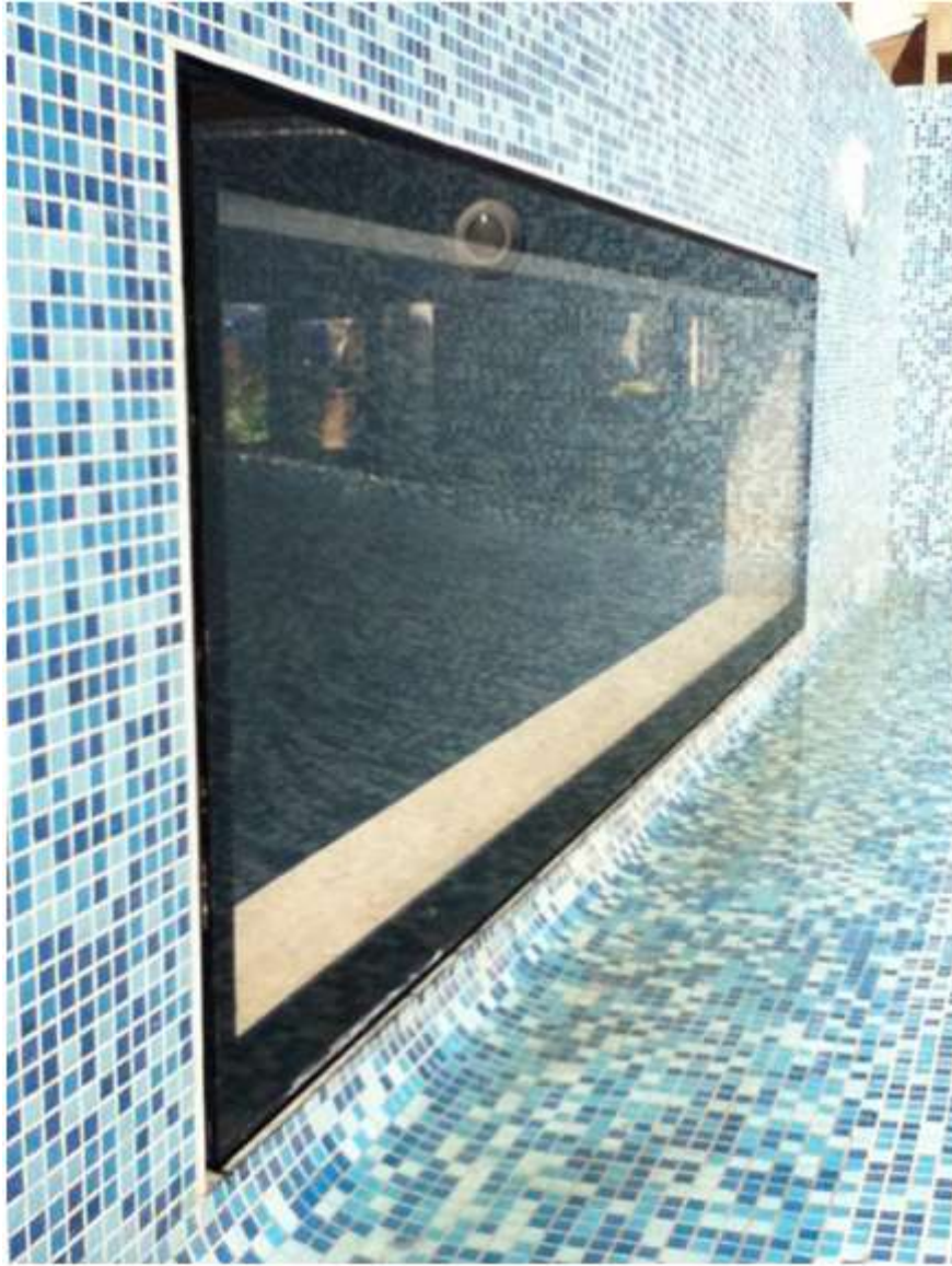
La pared ya está con sus azulejos - la ventana quedará al ras de las baldosas
