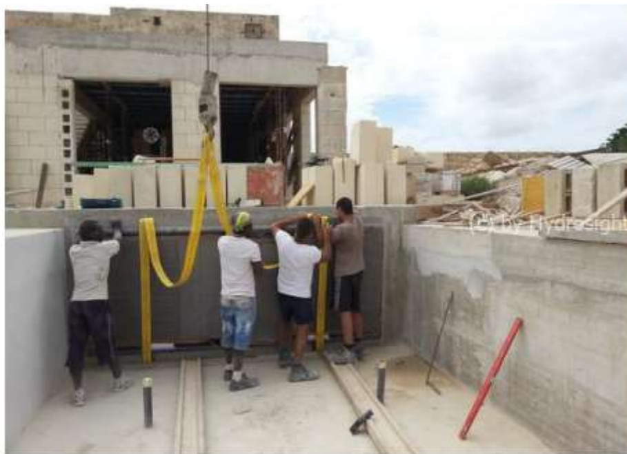
Colocación de la ventana en el hueco de la pared
